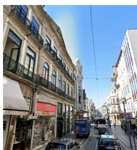
Rua de Sta. Catarina nº 53
